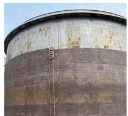
TK-95 während der Entschichtung
