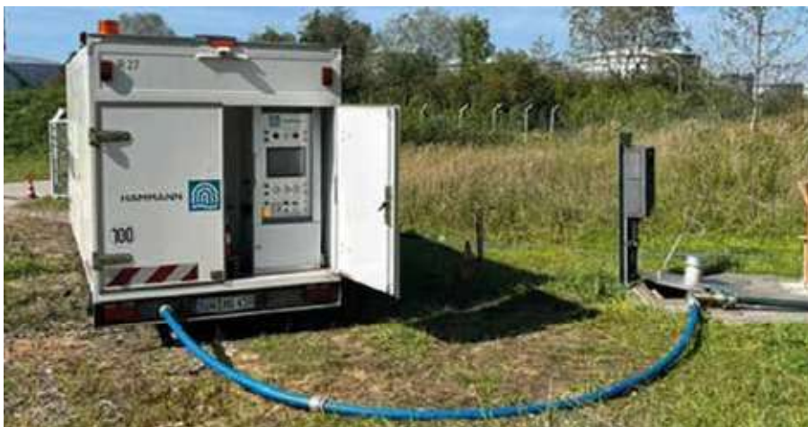
Die Druckluft wurde über einen mobilen Luftkompressor erzeugt, anschließend mit Wasser gemischt und am Rohrleitungsbeginn eingebracht.
